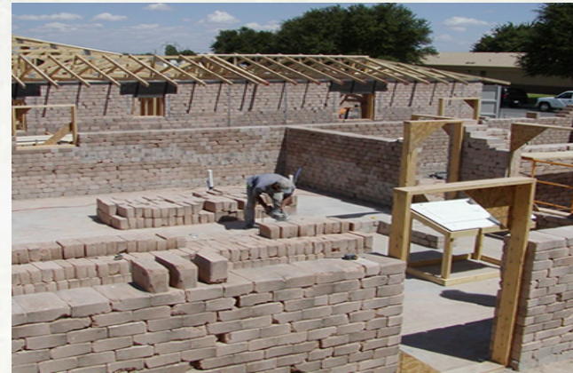
Una obra siendo completamente construida con Bloques y Ladrillos hechos con Natural Crete
